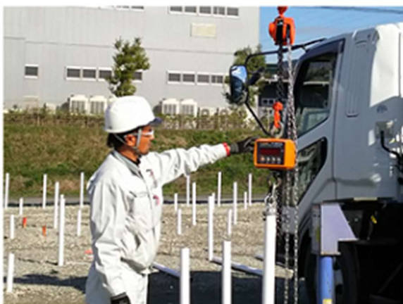
杭の支持力性能試験のイメージ
